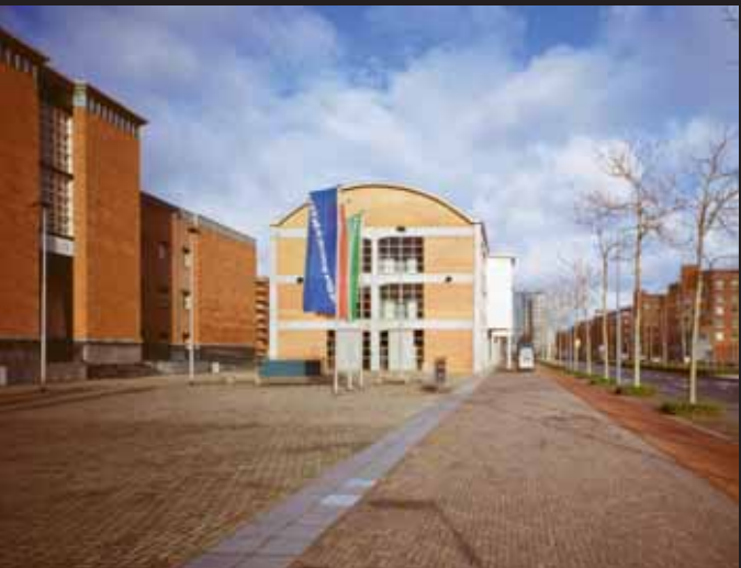
Maastricht. Wiebengahal (reconstruction: Hubert Jan Henket Architecten)
