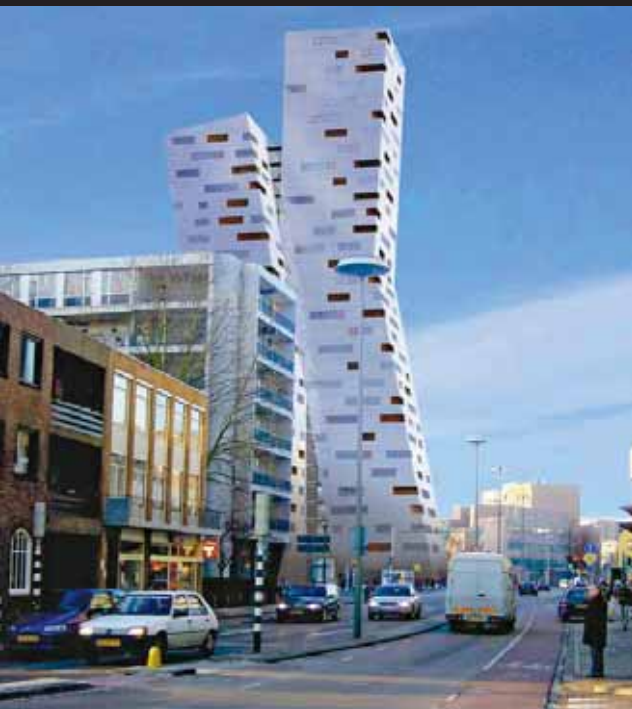
Heerlen. Woontoren Van Grunsvenplein (Mecanoo)
