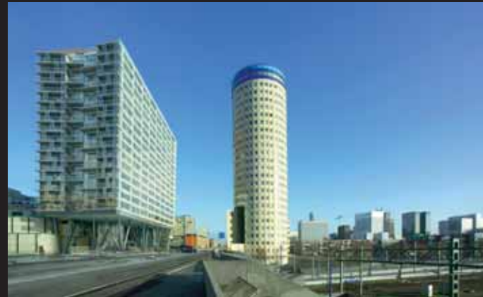
The Hague. La Fenêtre (Architectenbureau Rudy Uytenhaak)
